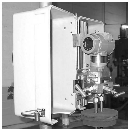
RMT3051C смонтирован на монтажном мостике (DS4000)
